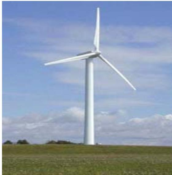
Fig. I. 4 : Aérogénérateur à axe horizontal.
